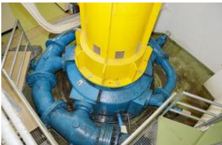
Dieser Generator (Teilbereich der Turbinenanlage) liefert den Strom für die Stricker & Cie AG.
